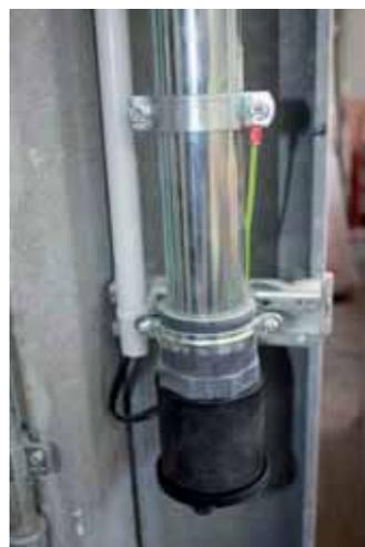
Presa aspirante antistatica con collegamento di terra.
